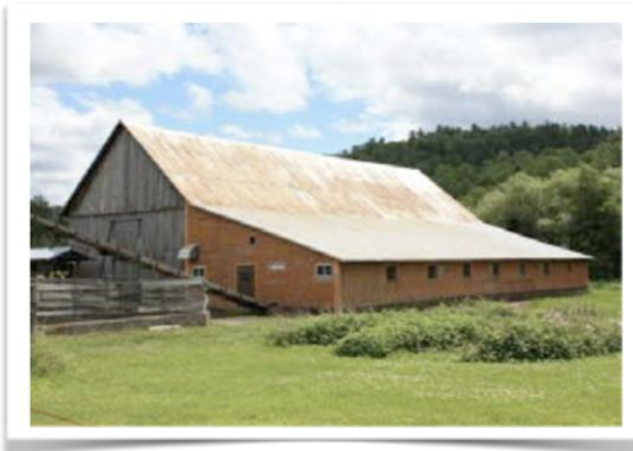
Grange-étable Chemin du chevreuil blanc Estimation 1890, Valeur patrimoniale 3, bon état
