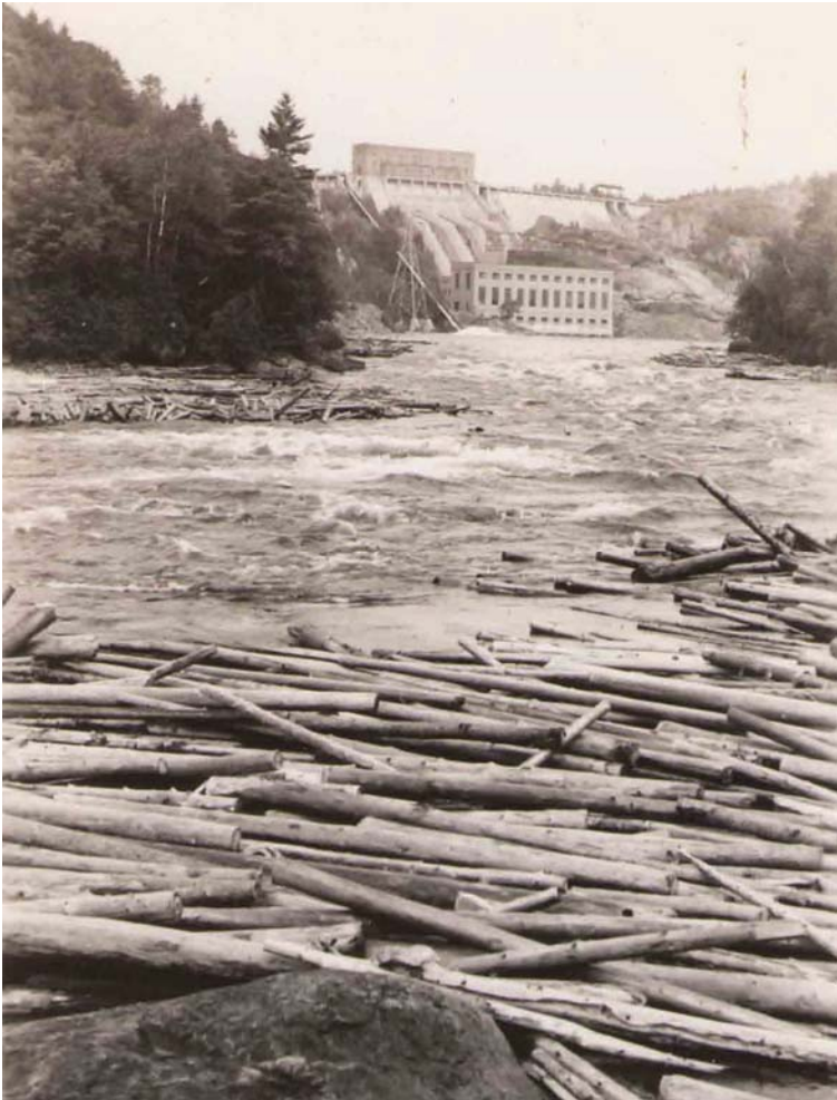
Le barrage de High Falls et son glissoir en acier, qu'on aperçoit à gauche.
