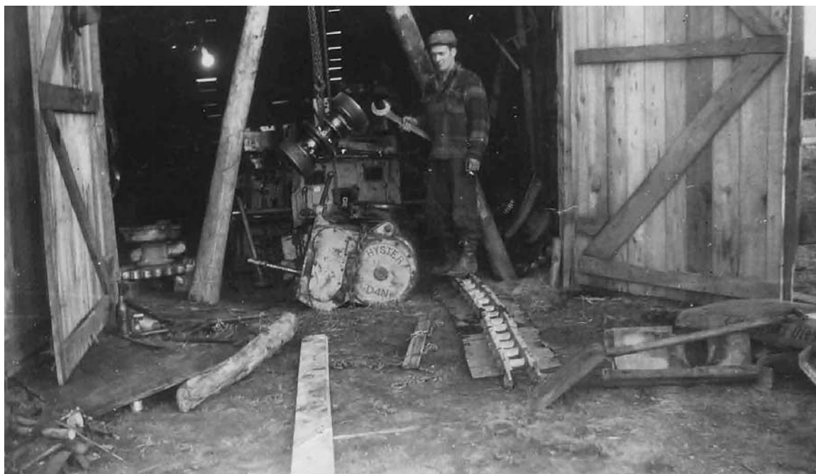
Régis Fleurant faisant l'entretien de la machinerie nécessaire au chantier d'Evariste Fleurant. Source : Cécile Fleurant Larocque
