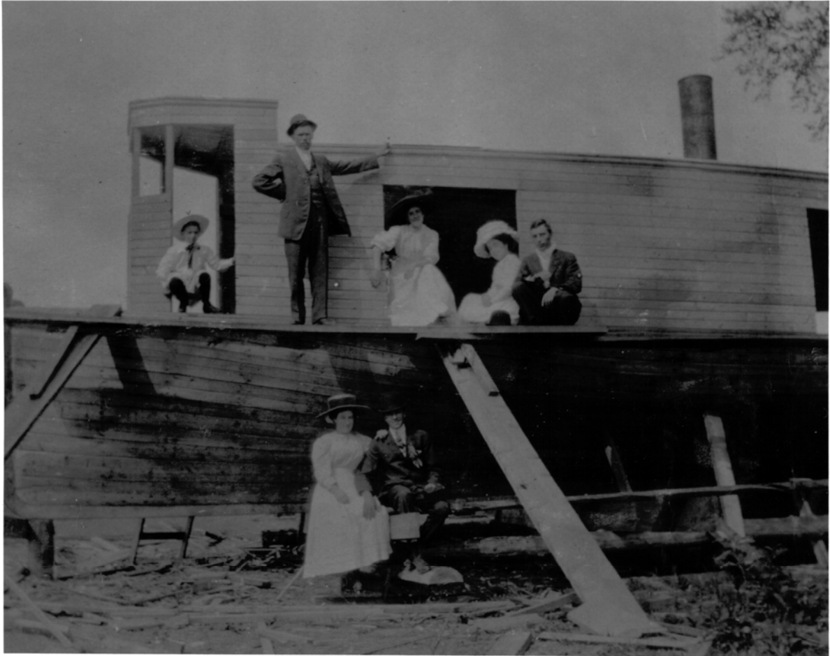
Un des vapeurs de la Lièvre sur son chantier de construction. Source : Agathe et MarietteLarocque.
